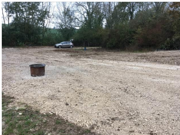
Photo 1 : Plateforme du chantier de forage
